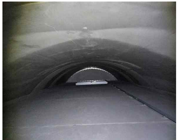
신월여의지하도로 (여의도방향) 풍도슬래브
