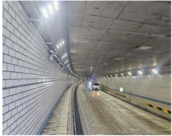
신월여의지하도로 (여의도방향) BOX구간
