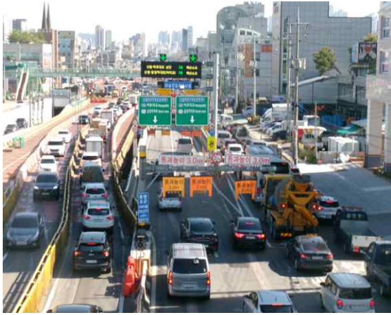
신월여의지하도로 (여의도방향) 진입부
